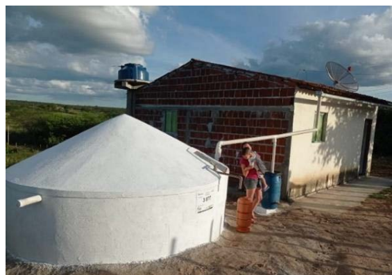
Cisterna escolar de 52 mil litros
