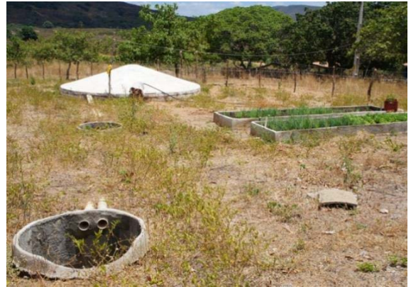
Cisterna de enxurradas de 52 mil litros
