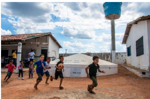
Cisterna de placas de 16 mil litros
